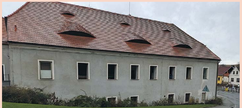
Obec Kout na Šumavě se v závěru roku pustila do rozsáhlé rekonstrukce obecního úřadu. Je rozdělena do dvou etap, výměna oken a výměna dveří s opravou fasády. Výměnou oken se vrátí původní vzhled Tvrze a sníží náklady na provoz budovy. Bohuš Havlovic, starosta
